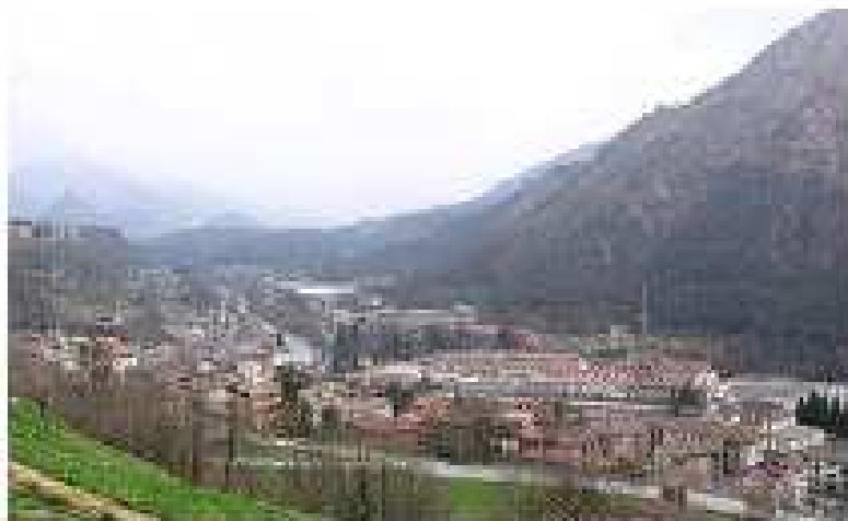
Il complesso industriale ex Cottonificio, oggi
